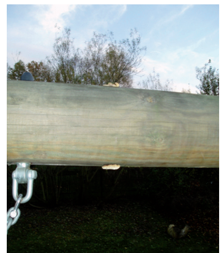
Abbildung 1: Pilz im Querbalken: Stabilität nicht mehr sichergestellt (Quelle VDSI).
