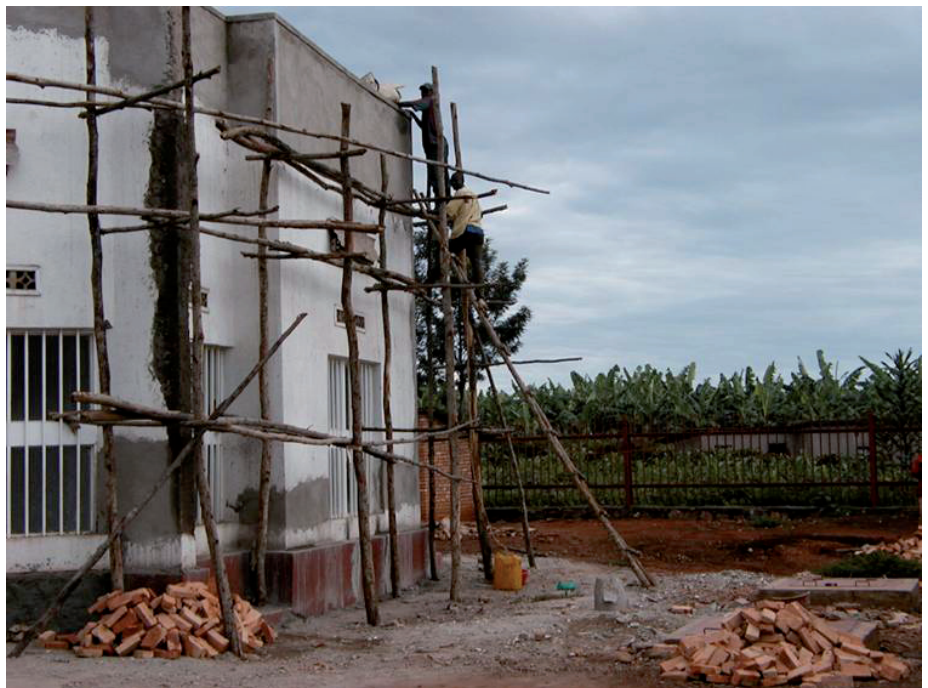
Bild 9: Gerüste werden meist aus einfachen Hölzern erstellt
