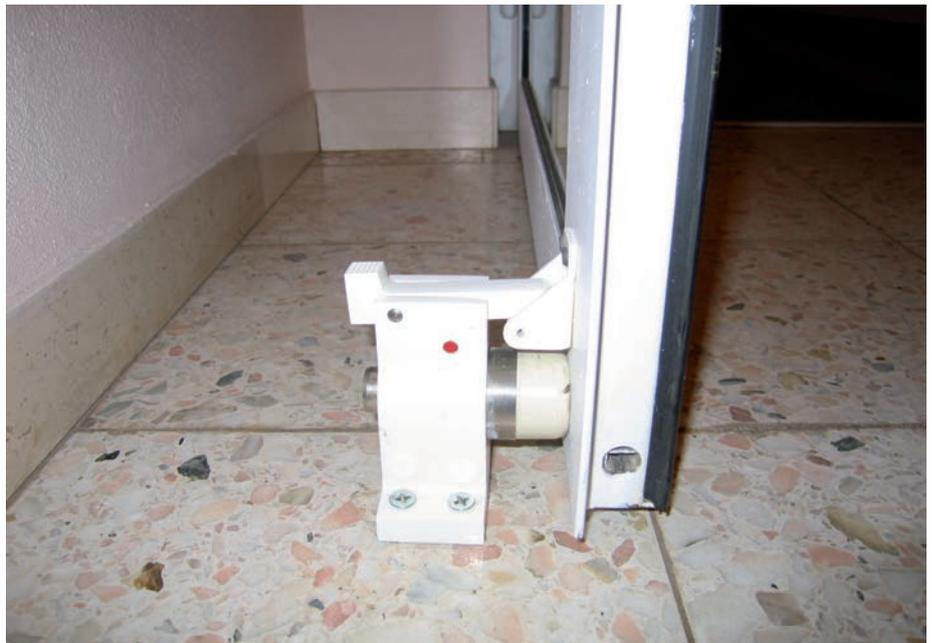
**Abbildung 5:** Negativbeispiel zum planmäßigen Offenhalten einer Rauchschutztür (Verriegelung durch Feststeller)
