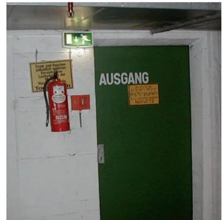
**Abbildung 2:** Negativbeispiel für die Anbringung eines Feuerlöschers (zu hoch)
