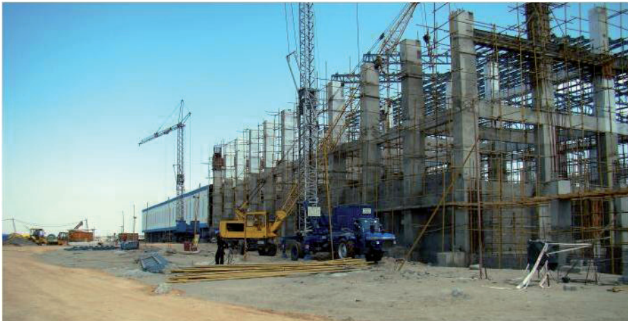
Abbildung 2: Großbaustelle in Indien
